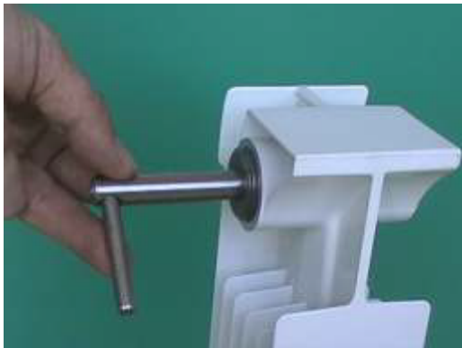
1: Inserimento della fresa di pulizia della filettatura nel mozzo del radiatore.
